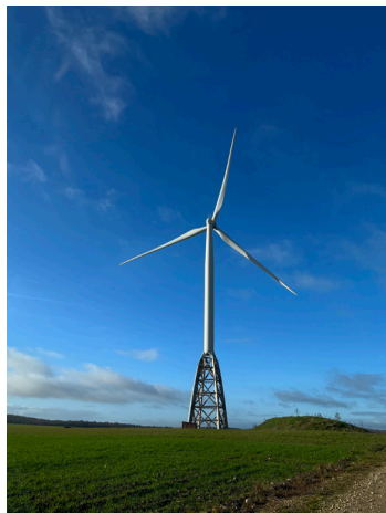
Mât en bois, Essey-les-Ponts, France
